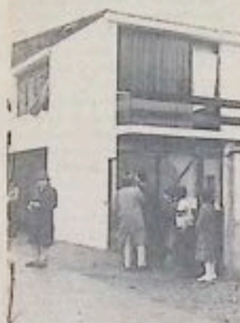
Una de las ocho viviendas que sufrieron destrozos en sus ventanas por la onda expansiva de las dos explosiones. Esta casa sufrió los peores perjuicios.
